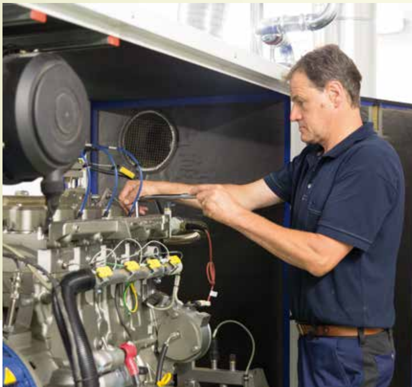
Foto links: Wartungsarbeiten Blockheizkraftwerk
