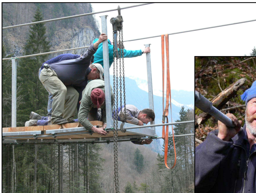
Gross und Klein helfen beim Brückenbau in der Aaschlucht mit.
