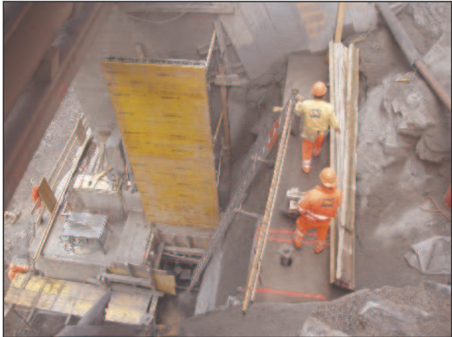
Am Lehnenviadukt wird mit Hochdruck gearbeitet.
