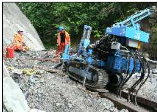
Bohrarbeiten zur Hangsicherung.
