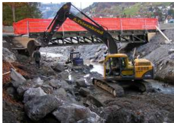
Arbeiten an den Ufern der Engelbergeraas.
