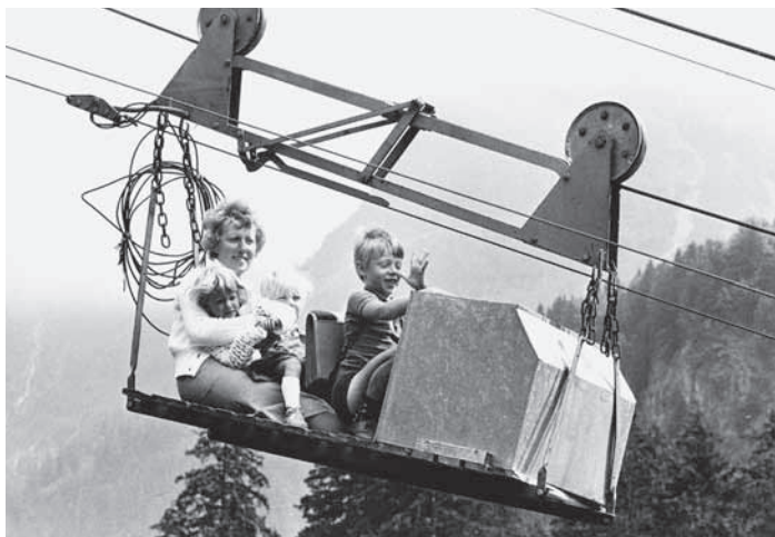
Diese wasserbetriebene Pendelbahn führte von 1925 bis 1980 auf die Füreinalp.
