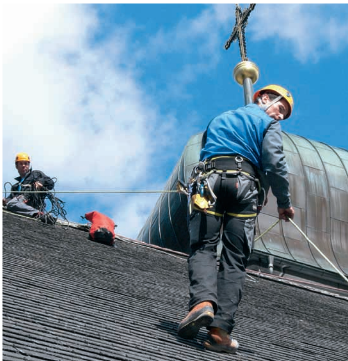
Bergführer montieren auf dem Kirchendach eine Blitzschutzanlage (Foto: Beat Christen).
